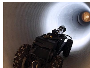
Inspección de tuberías
